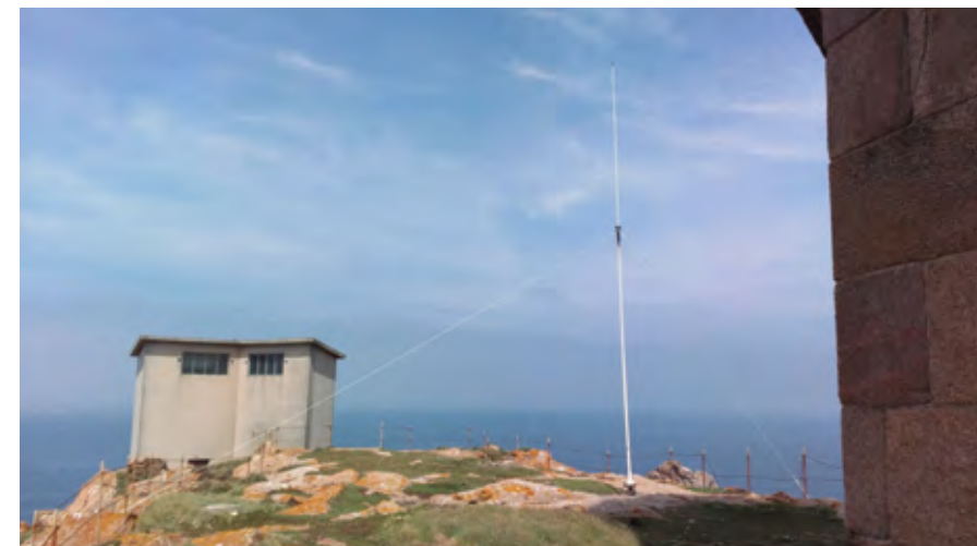
Antena emisora do Radar HF na estación de Cabo Vilán.
